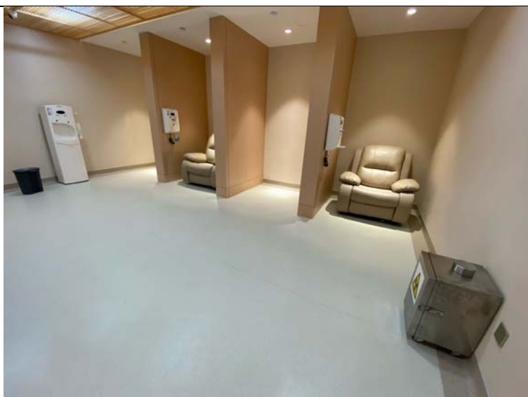
SPECT 候诊室内设 2 人候诊位，之间设置铅防护
