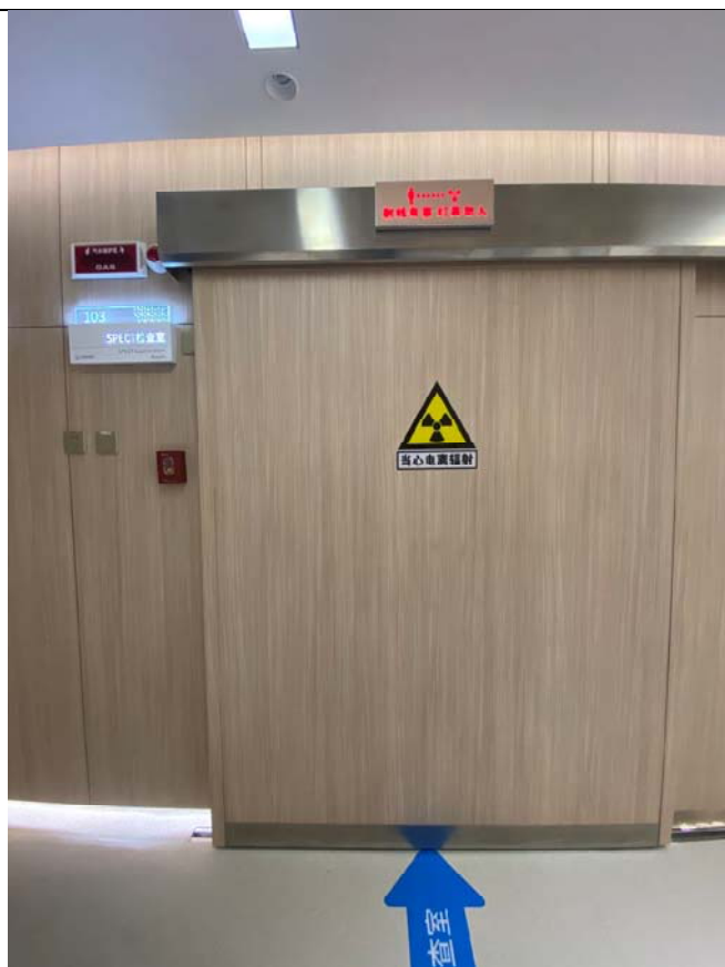
SPECT 机房电离辐射警示标志
