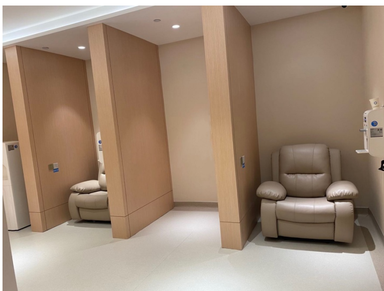
PET 候诊室内设 2 人候诊位，之间设置铅防护隔离措施
