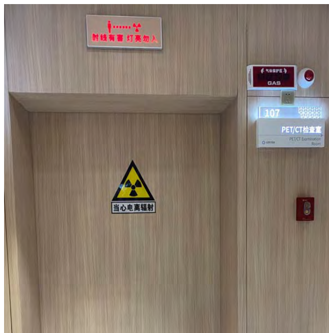
PET/CT 机房警示标志和警示等灯箱
